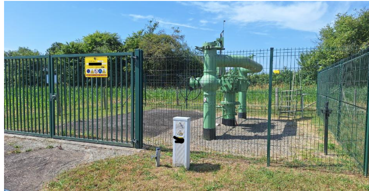
Exemple de poste de sectionnement (DN900)
